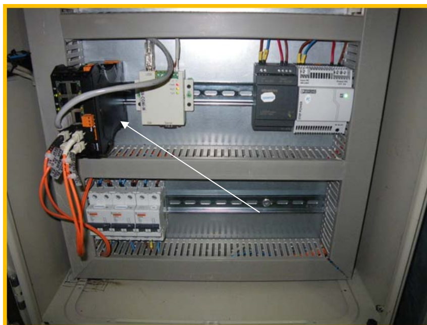
Foto 3: Equipo instalado en máquina.
