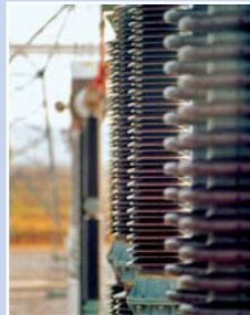
Detalle de la cerámica aislante
