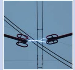
Salto de electricidad a través del aire
