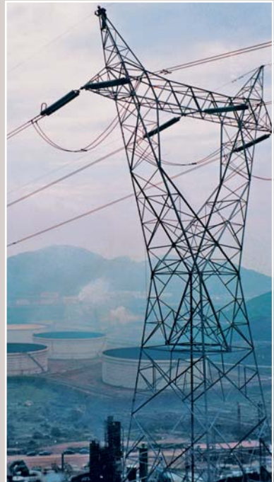
Cuanto mayor es la tensión menores pérdidas se producen en el transporte
