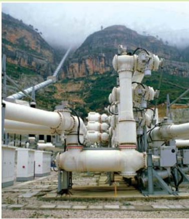
Central de bombeo: en las horas de poco consumo se bombea agua y se deja caer cuando se precisa generar otra vez electricidad
