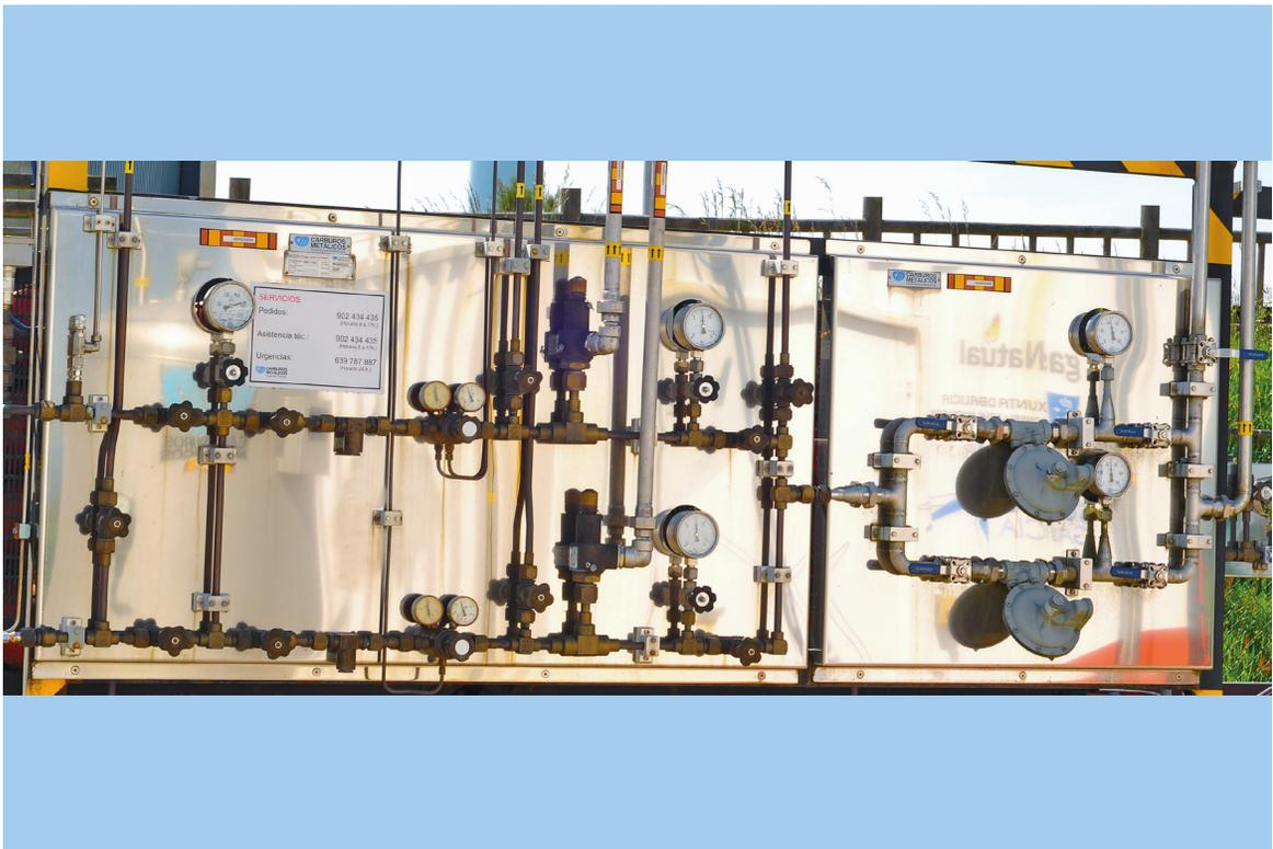
AF 18. Detalle sistema de descompresión
