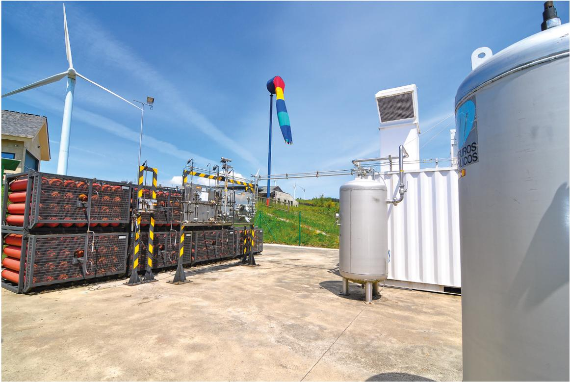
AF 17. Sistema de almacenamiento, panel de descompresión y buffers
