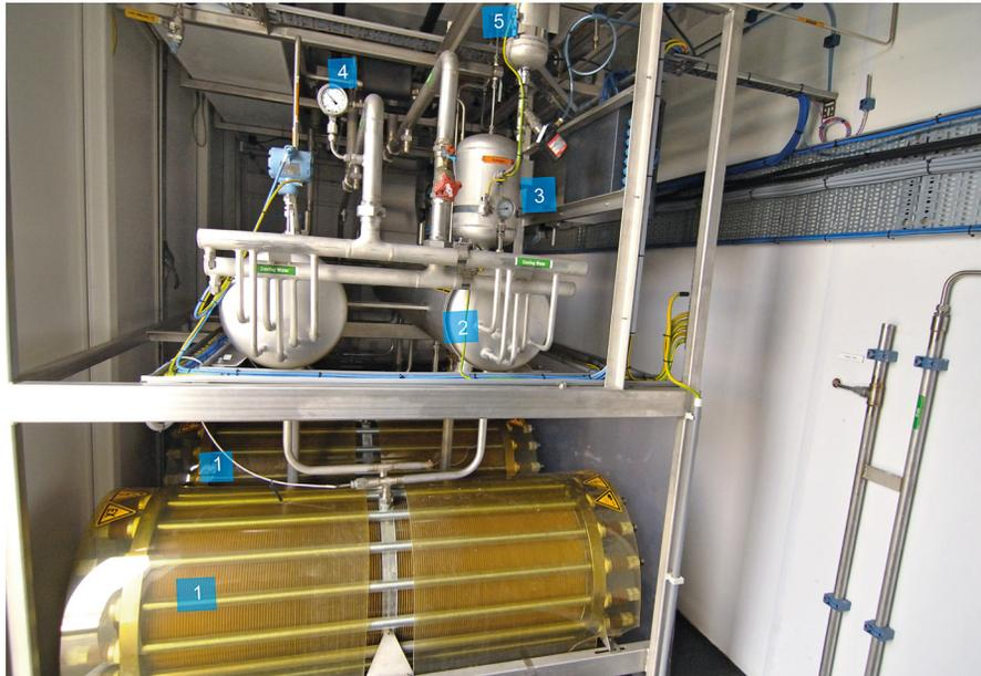
Figura 14. Vista general del electrolizador. (1) stack de celdas, (2) separador de gas, (3) depósito de lavado (4) intercambiador de calor, (5) sistema de llenado
