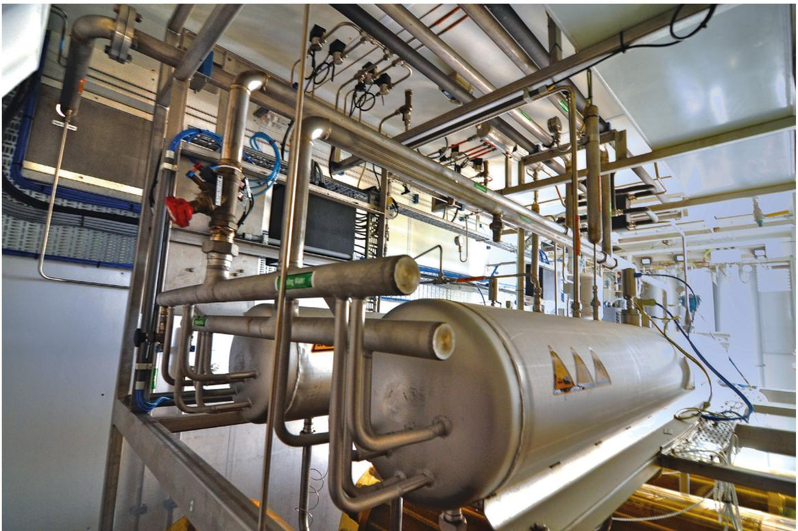
AF 11. Separadores de gas, depósito de lavado y sistema de alimentación de agua
