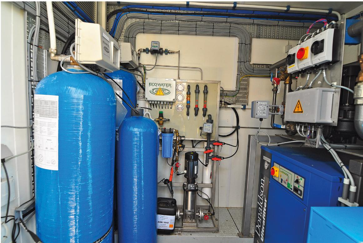
AF 6. Sistema de filtración físico, químico y bacteriológico del proceso de osmosis
