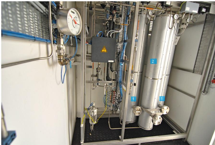
Figura 15. Columnas de secado (1) y DEOXO (2)
