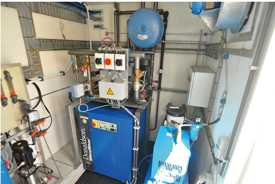
AF 7. Intercambiador refrigeración del electrolito y compresor del sistema neumático
