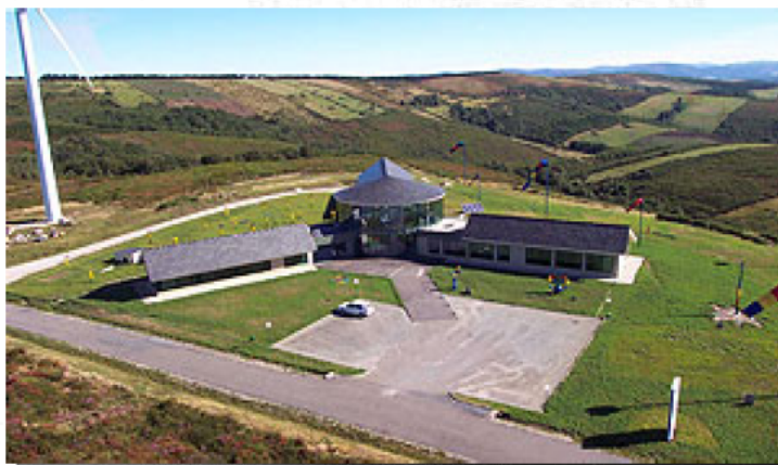
SOTAVENTO. Imaxe aérea das instalacións divulgativas de Sotavento, a carón dos aerogeneradores eólicos
