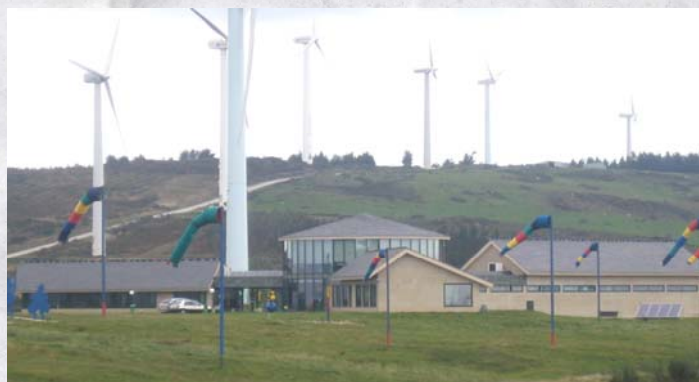
En Sotavento se realizan desde 1997 experimentos con todo tipo de energías renovables
