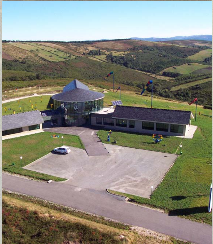
Edificio divulgativo del Parque Eólico de Sotavento
