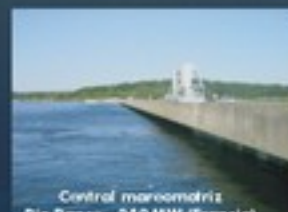
Control mareométrico Rio Rance - 240 MW (Francia)
