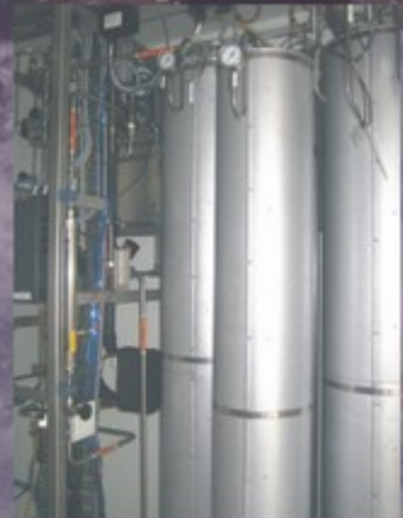
Equipos do proxecto de acumulación de H 2 do Parque Eólico Experimental Sotavento.
