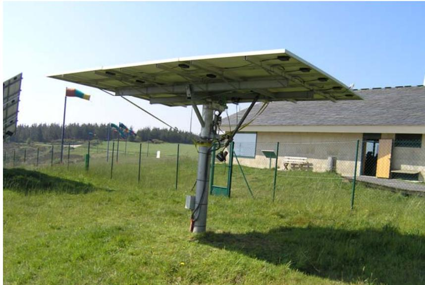
ILUSTRACIÓN 24 Seguidor solar averiado puesto en bandera para evitar ser dañado por vientos fuertes
