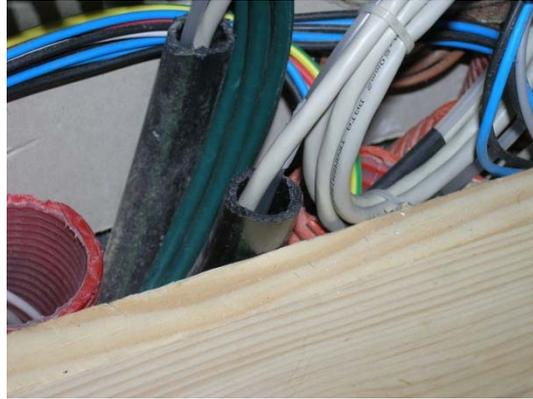
ILUSTRACIÓN 25 Tuberías portadores de sensores de temperatura
