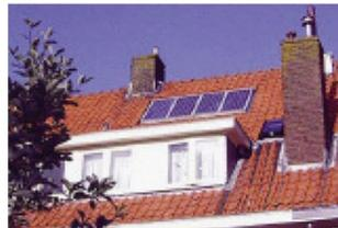
Ejemplo de una instalación Fotovoltaica con 4 paneles solares de 120 Wp compatibles con la potencia pico del Soladin 600. Ahorro de energía, dependiendo del uso, hasta un 12%.
