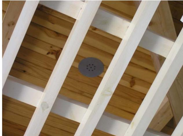
ILUSTRACIÓN 27 Sensor de temperatura del techo dentro de una cavidad
