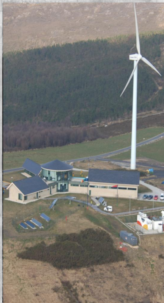
Vista de las instalaciones, situadas al sur de As Pontes
