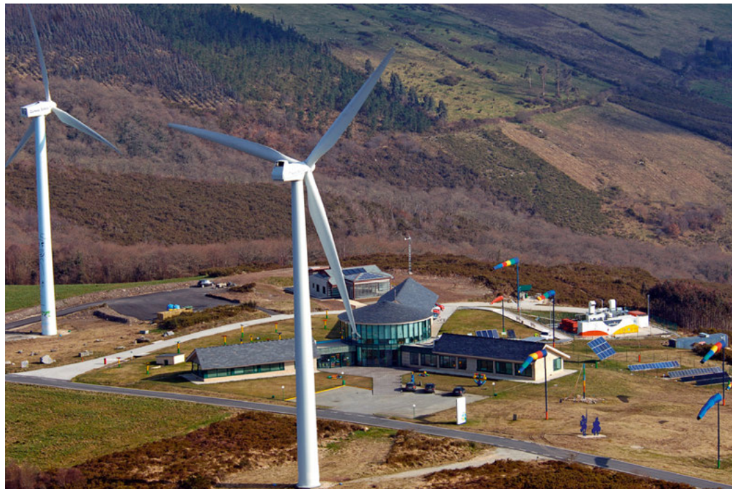
Figura 4 Vista aérea edificio multifuncional del parque
