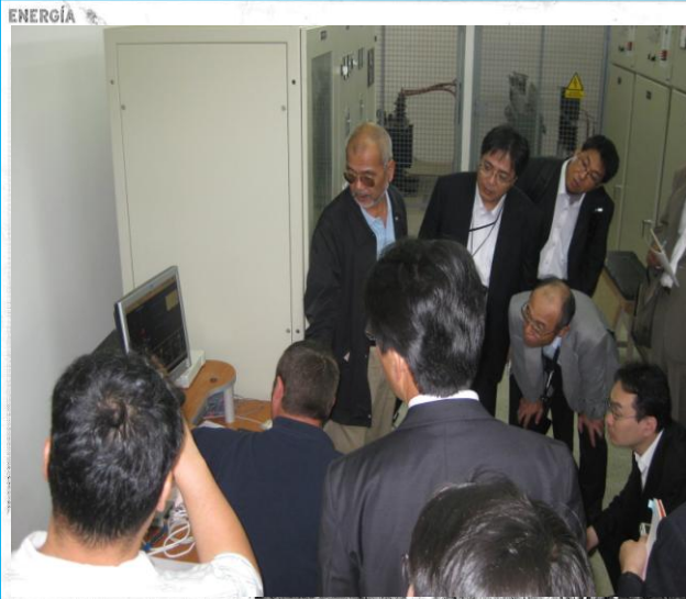
Un momento del recorrido de los ingenieros nipones por las instalaciones del complejo
