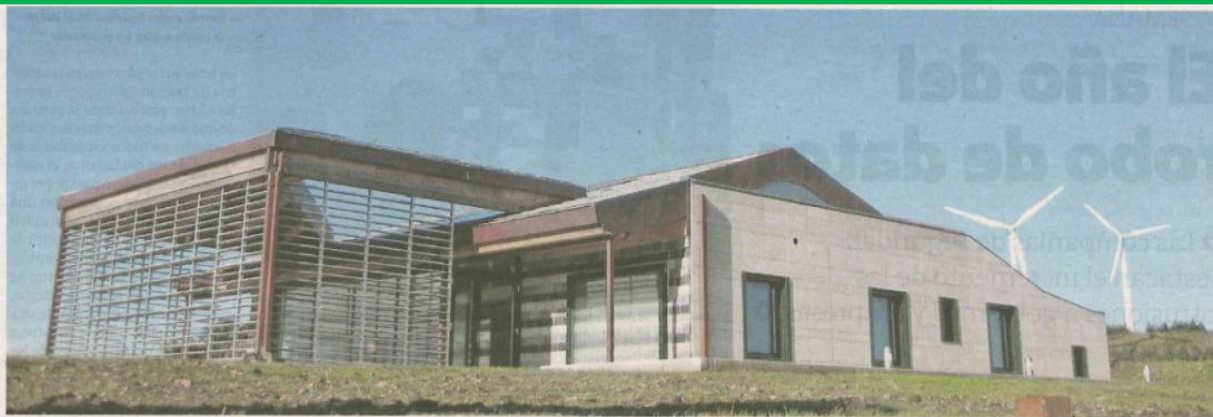
La vivienda bioclimática de Sotavento, exteriormente dividida en dos cuerpos claramente diferenciados, ocupa una superficie superior a 200 metros cuadrados.
