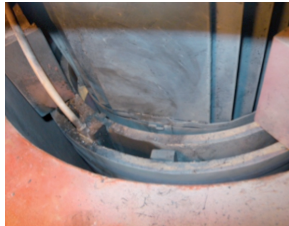
Figura 2. Detalle siniestro de transformador por puesta a tierra del cableado interruptor ppal-transformador.
