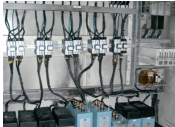
Figura 11. Estado inicial (izquierda) con tiristores y reformado (derecha) con contactores, MADE AE61.
