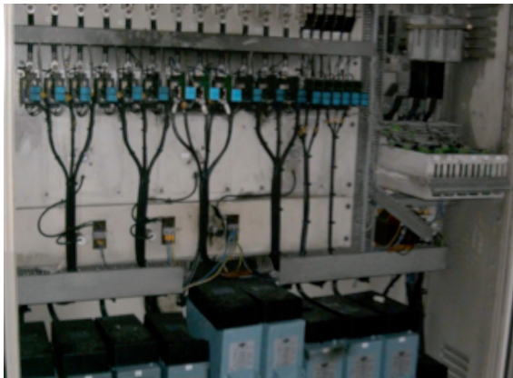
Figura 11. Estado inicial (izquierda) con tiristores y reformado (derecha) con contactores, MADE AE61.
