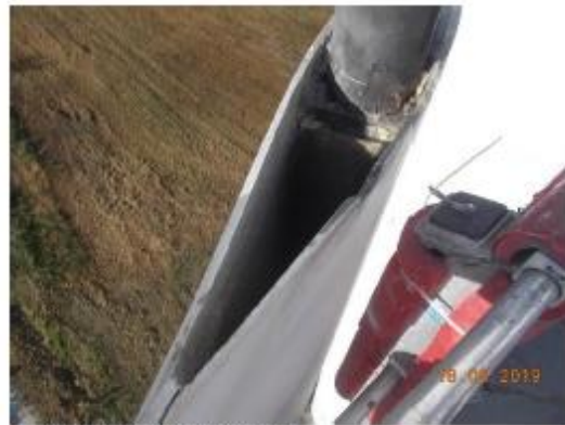
Foto 2: Saneado y limpieza
