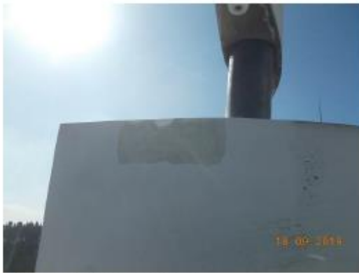
Foto 7: Proceso de saneado
