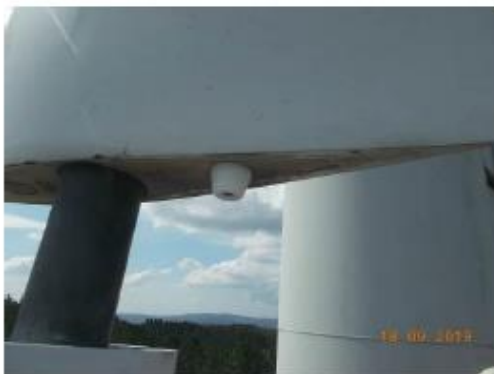
Foto 15: Colocación cono BS
